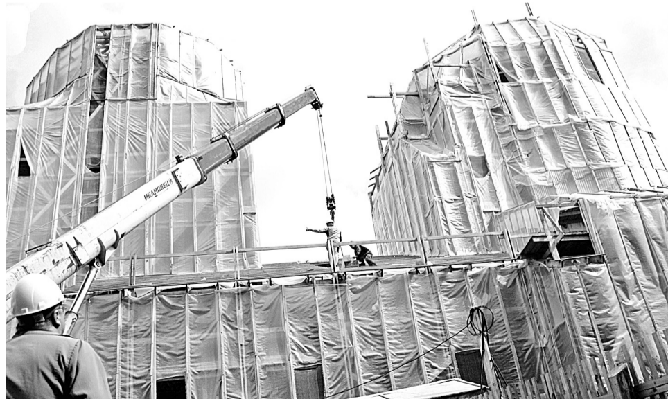
Подъём бруса для перекрытий
