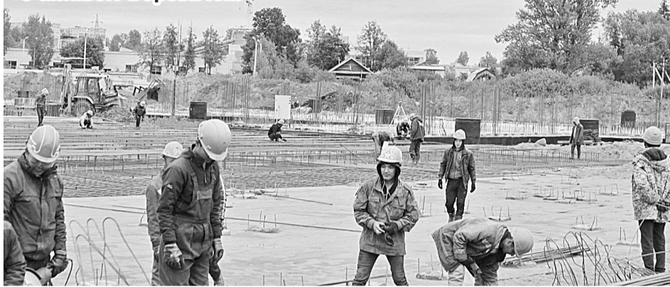
Армирование фундамента новой школы
